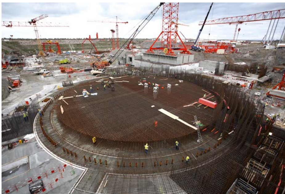
Le chantier EPR à Flamanville en décembre 2007 (EDF Médiathèque – Alexis MORIN) Ferrailage du radier du bâtiment réacteur
