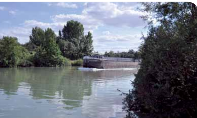
Le projet de VNF devrait permettre à des péniches à grand gabarit d'accéder aux ports de Nogent-sur-Seine depuis l'écluse de la Grande Bosse.
