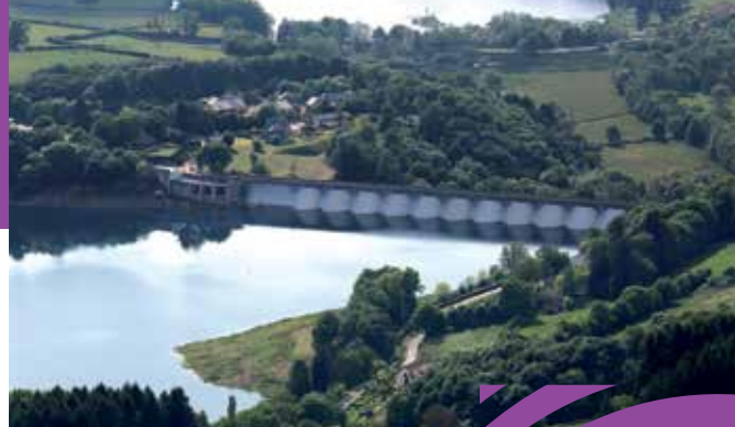
Barrage de Pannecière et bassin de compensation EDF
